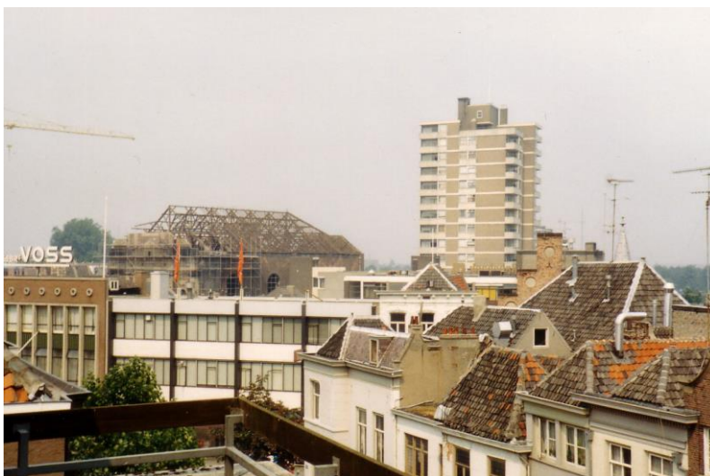
De sloop van de Sint Pieter is een feit. Nadat het torentje verwijderd was, volgde het dak en de voorgevel. Situatie augustus 1982, gezien vanaf het dak van Vroom & Dreesmann aan de Pensmarkt.
